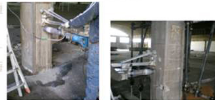
Estrazione di carote da pilastri dei corpi di fabbrica del complesso ex ATICARTA
